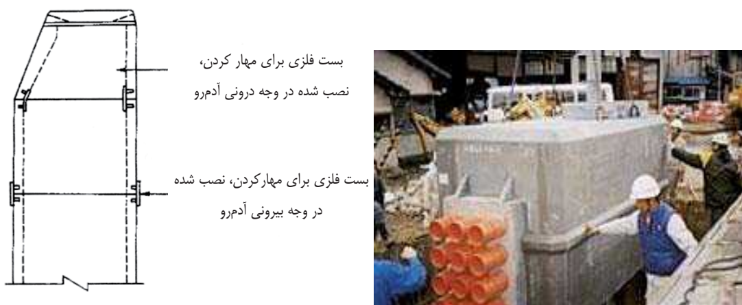
شکل ۷-۲ نمونه اقدامات ضد لرزه‌ای در آدم روی درجا و پیش‌ساخته
