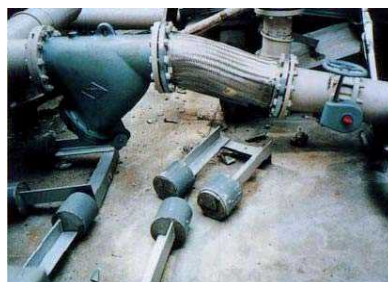
شکل ۹-۱ آسیب دیدگی اتصال لوله در اثر تغییر مکان مستقل پی
