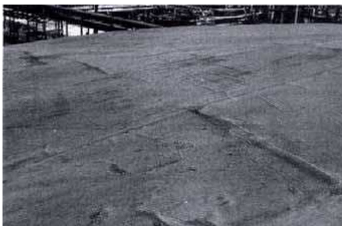
شکل ۶-۲۸ پوشش سقف بطانه‌ای
