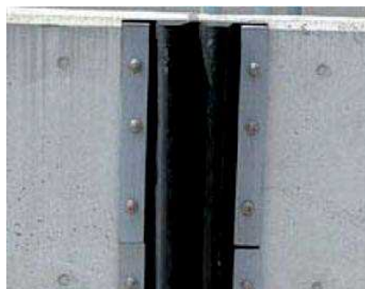
شکل ۶-۱۰ درز با مصالح انعطاف‌پذیر
