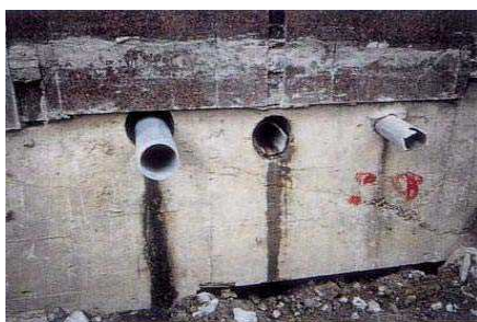
شکل ۹-۴ لوله کشی در محل اتصال با ساختمان
