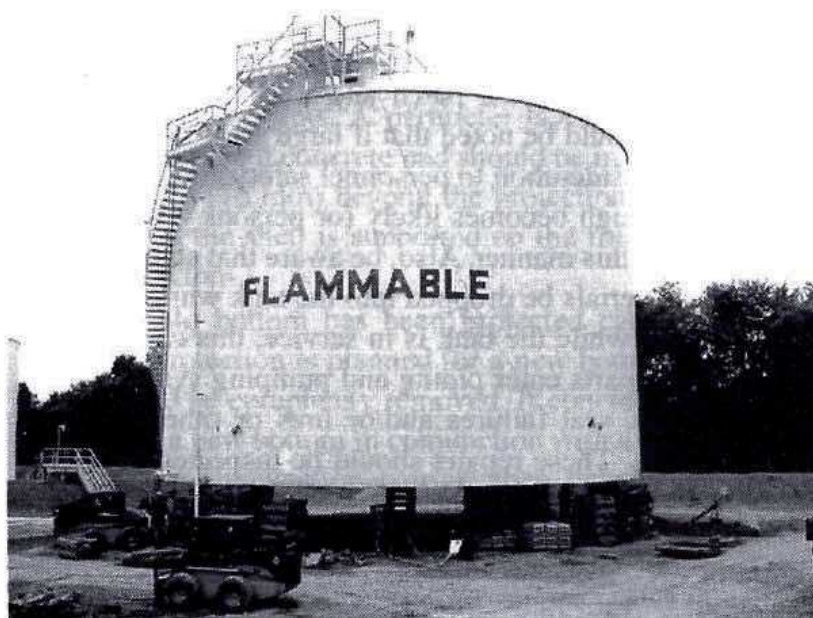
شکل ۶-۱۹ مخزن بلند شده برای تعمیر لایه زیری
