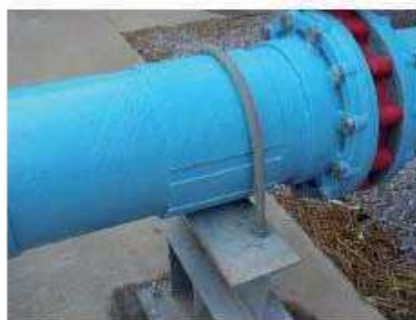
شکل ۵-۷ آرایش پیچ U شکل
