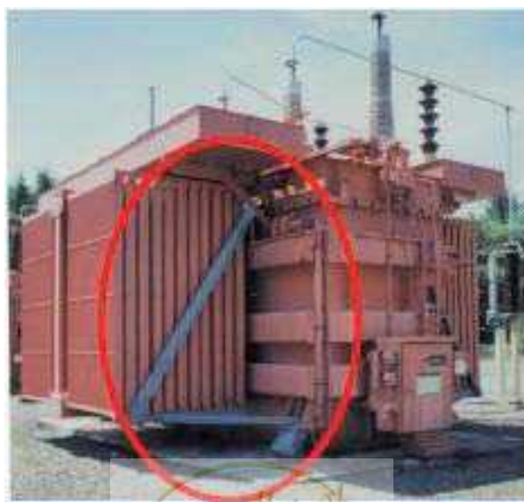
شکل ۵-۵ تقویت مهار بندی رادیاتور ترانس
