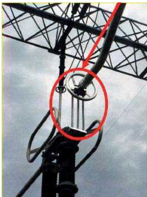
شکل ۸-۵ تعبیه سوئیچ قطع برای کنترل عملکرد تجهیزات
