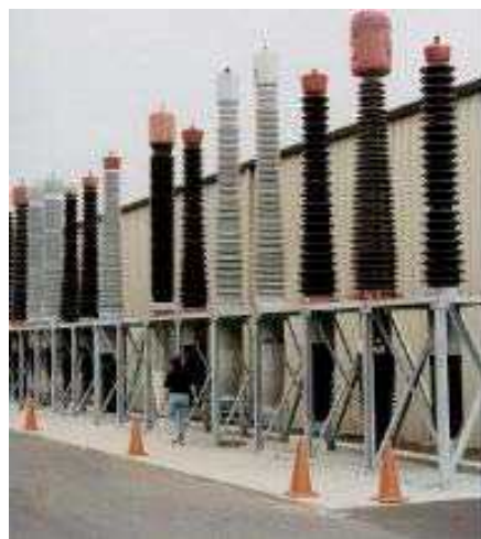
شکل ۱۲-۵ مه‌ار بندی تجهیزات یدکی در انبار
