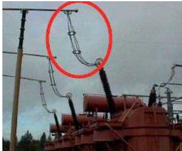
شکل ۵-۶ بهسازی اتصال بوشینگ برای کنترل مد شکست اتصال و نشست روغن
