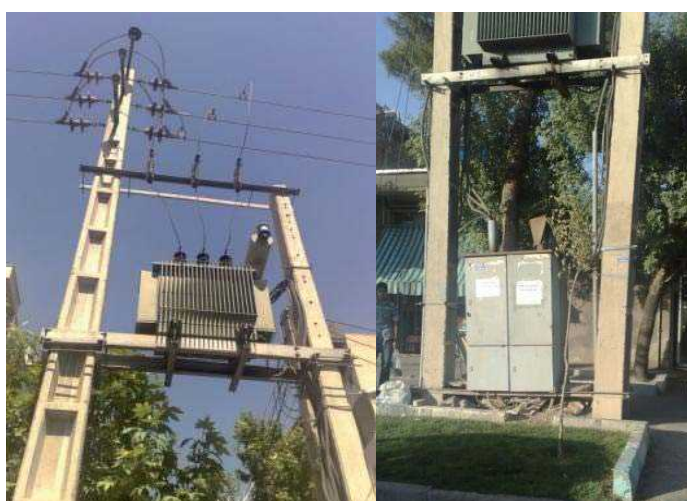
شکل ۵-۱۴ پایه‌های توزیع و ترانس هوایی
