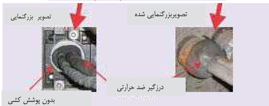
شکل ۲۲-۵ آب‌بندی اتصال مجرای انتقال کابل
