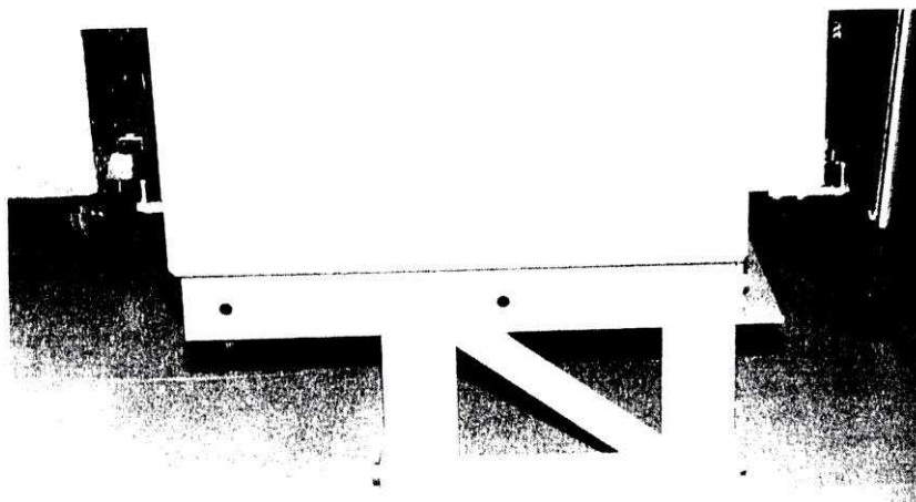
شکل ۵-۸- استفاده از بدستال سازه‌ای در کف کاذب
