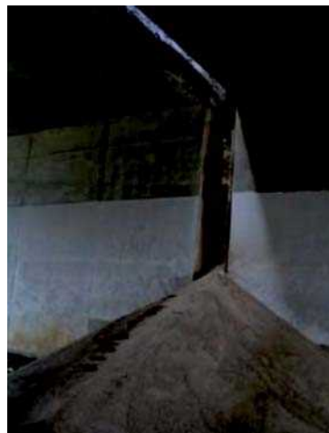
شکل ۵-۶۲ درز ایجاد شده در مجرای بتنی با مقطع مربعی در اثر زلزله
