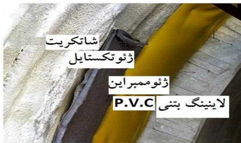
شکل ۶-۲۱- شماتیک لایه‌بندی سیستم نگهداری و آب‌بندی تونل
