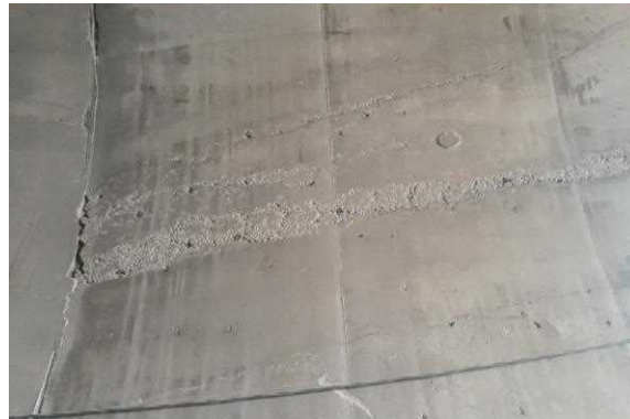
شکل ۶-۱۵- نمونه ای از درز سرد در بتن لاینینگ
