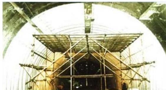
شکل ۶-۲۰- اجرای عایق بندی
