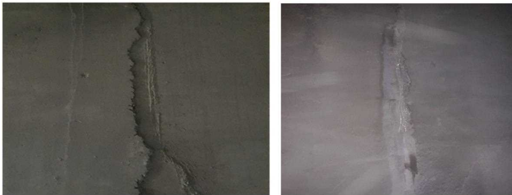
شکل ۶-۱۶- درزهای اجرایی در بتن لاینینگ
