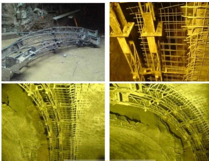
شکل ۷-۴- لتیس‌گریدر و نصب آن
