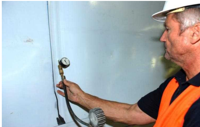
شکل ۵-۲۲- تست فشار هوا برای عایق بندی تونل
