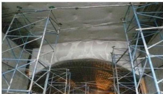
شکل ۶-۲۰- اجرای عایق بندی
