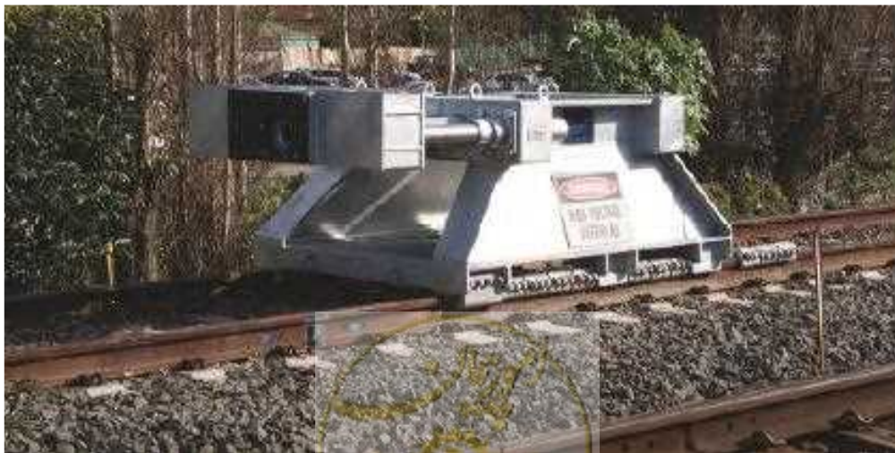
شکل ۱۱-۰ نمونه ای باز بافر استاپ های ترکیبی (لغزنده-هیدرولیکی)
