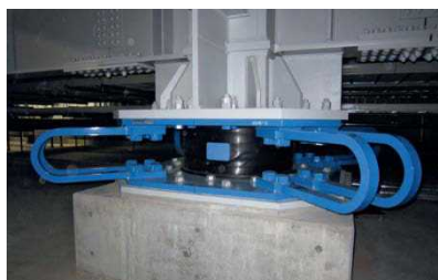
(ب) میراگر تسلیمی فولادی U-شکل
