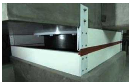
شکل ۱۴-۱۷۲- لزوم سازگاری صفحات محافظ آتش با تغییرشکل جداساز لرزه‌ای
