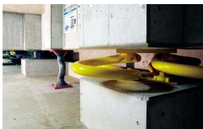
(ج) میراگر تسلیمی سربی و تسلیمی فولادی
