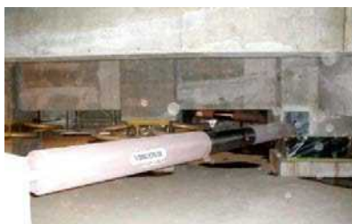
(ث) میراگر ویسکوز و تسلیمی فولادی
