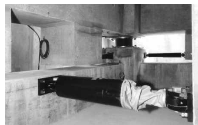
(ت) میراگر ویسکوز
