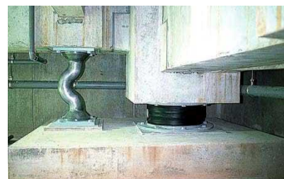
(الف) میراگر تسلیمی سربی
