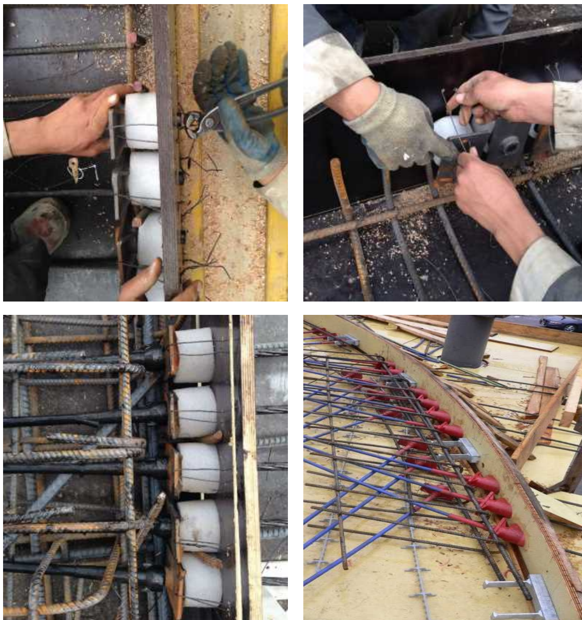
چ نحوه اجرای سر زنده تاندون‌ها در لبه قالب دال و آرماتوربندی اطراف آن در سیستم نچسبیده (انتهای کششی به قالب جداره متصل شده و تاندون‌ها از گیره‌ها عبور داده می‌شوند)
