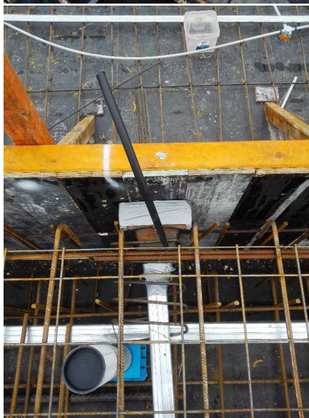
ج) نحوه اجرای سر زنده تاندون‌ها در لبه قالب دال و آرماتوربندی اطراف آن و تزریق دوغاب از طریق لوله تزریق ۱ تعبیه شده بر روی آن در سیستم چسبیده
