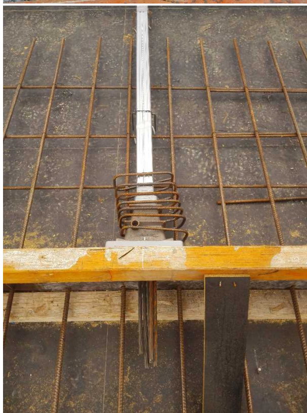
ج) نحوه اجرای سر زنده تاندون‌ها در لبه قالب دال و آرماتوربندی اطراف آن و تزریق دوغاب از طریق لوله تزریق ۱ تعبیه شده بر روی آن در سیستم چسبیده
