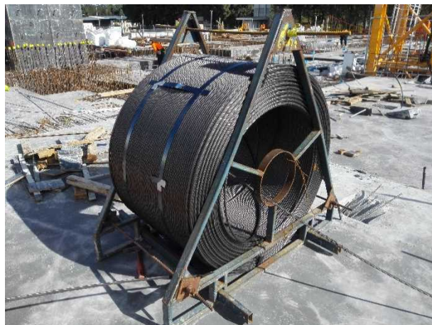
پ) فرقه تاندون‌ها و باز کردن تاندون‌ها و جایگذاری آن‌ها توسط ابزار هدایت از روی فرقه (انتهای مرده تاندون در فاصله ۵۰ میلی‌متری قالب جداره قرار می‌گیرد)
