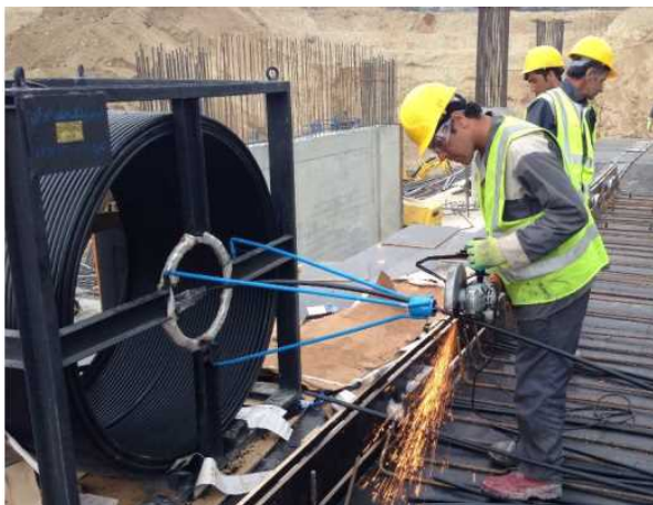
پ) فرقه تاندون‌ها و باز کردن تاندون‌ها و جایگذاری آن‌ها توسط ابزار هدایت از روی فرقه (انتهای مرده تاندون در فاصله ۵۰ میلی‌متری قالب جداره قرار می‌گیرد)
