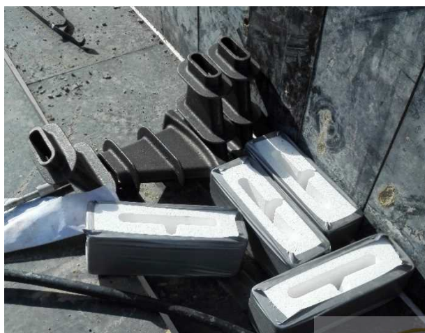
ب) گیره کششی و قالب حفره ی جلوی گیره در سیستم چسبیده
