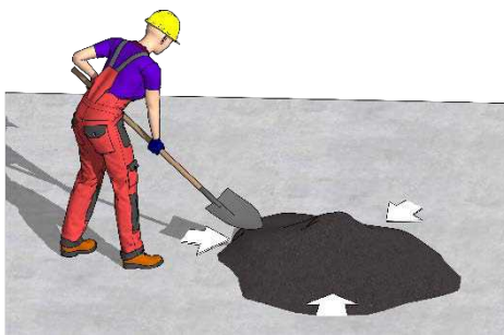
شکل ۱۳-۱- برداشت یکنواخت از همه کناره های دپو آسفالت
