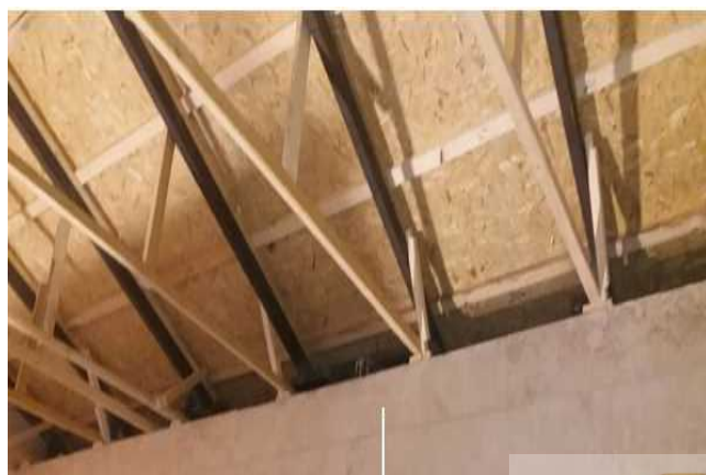
شکل ۸-۷۰- زیرسازی با چهارتراش‌های چوبی به فواصل حداکثر ۶۰۰ میلی‌متر که توسط پیچ به پروفیل‌های فولادی سقف سازه متصل شده
