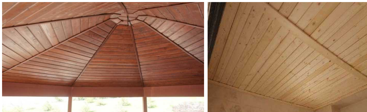
شکل ۸-۷۱- نمونه‌ای از اجرای سقف کاذب با لمبه‌های چوبی و رنگ‌های مختلف که توسط میخ فولادی به زیرسازی چوبی متصل شده اس
