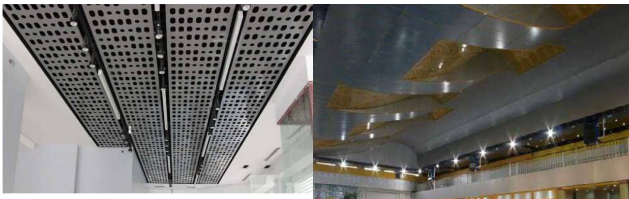
ب- ورق سوراخدار توسط دستگاه پانچ یا CNC
