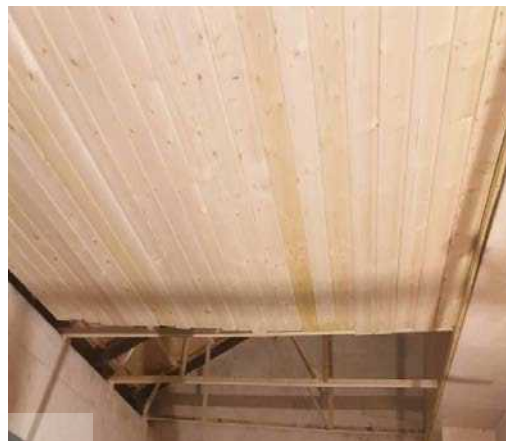
شکل ۸-۷۰- زیرسازی با چهارتراش‌های چوبی به فواصل حداکثر ۶۰۰ میلی‌متر که توسط پیچ به پروفیل‌های فولادی سقف سازه متصل شده
